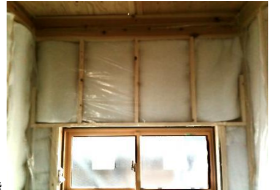
きれいに断熱材が入っているが、断熱材の波うち、隙間が直しきれていない。契約前にぜひどんな工事をする会社か見ておくべきです。
