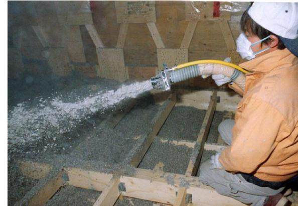
セルローズ断熱材を天井に吹き込む
